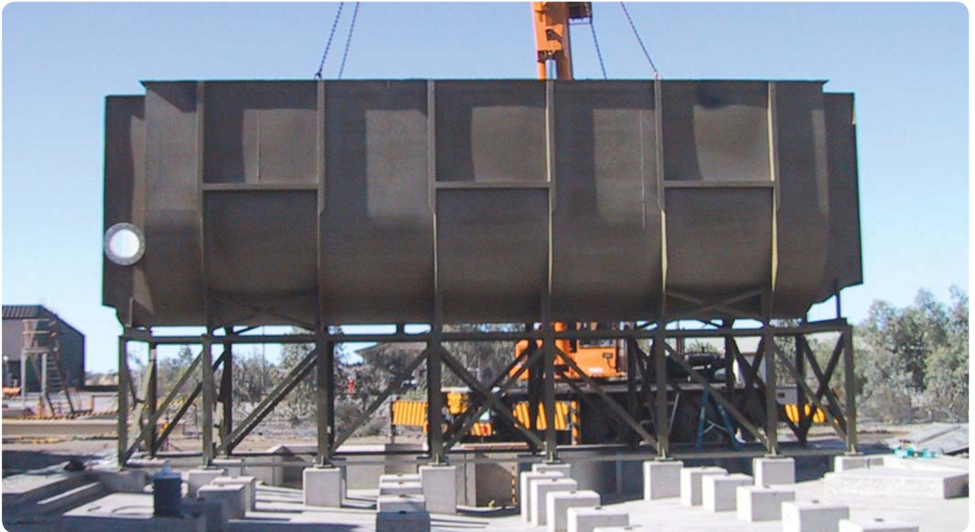
Instalación de estanque y estructura soporte del circuito zinc N° 3.
